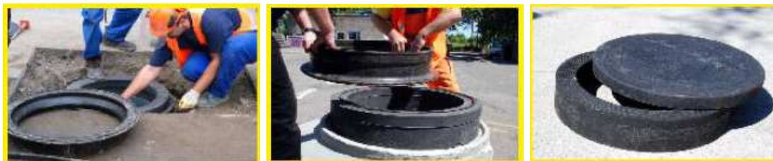
LATERBIT BG PLUS dostarczany w rolkach ok. 15 mb plastycznej uszczelki gotowej do bezpośredniego użycia. Alternatywą jest np. masa uszczelniająca klejąca na bazie polimerów np. SOUDASEAL 235 SF
